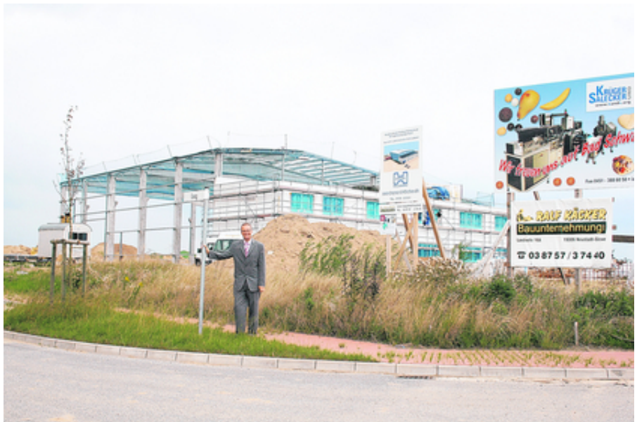
Jörg Maskov vor der Großbaustelle im Bad Schwartauer Gewerbegebiet Langenfelde-Nord. Vor einem Jahr stand der Alleininhaber der Maschinenbaufirma Krüger und Salecker schon mal dort – vor dem noch leeren Gelände. Foto: Makovec
